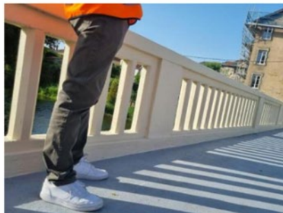
Sur le pont du lycée Poincaré, les garde-corps ont été entièrement remis en état et les trottoirs ont été recouverts d'une résine d'étanchéité. Photo Nicolas Galmiche
