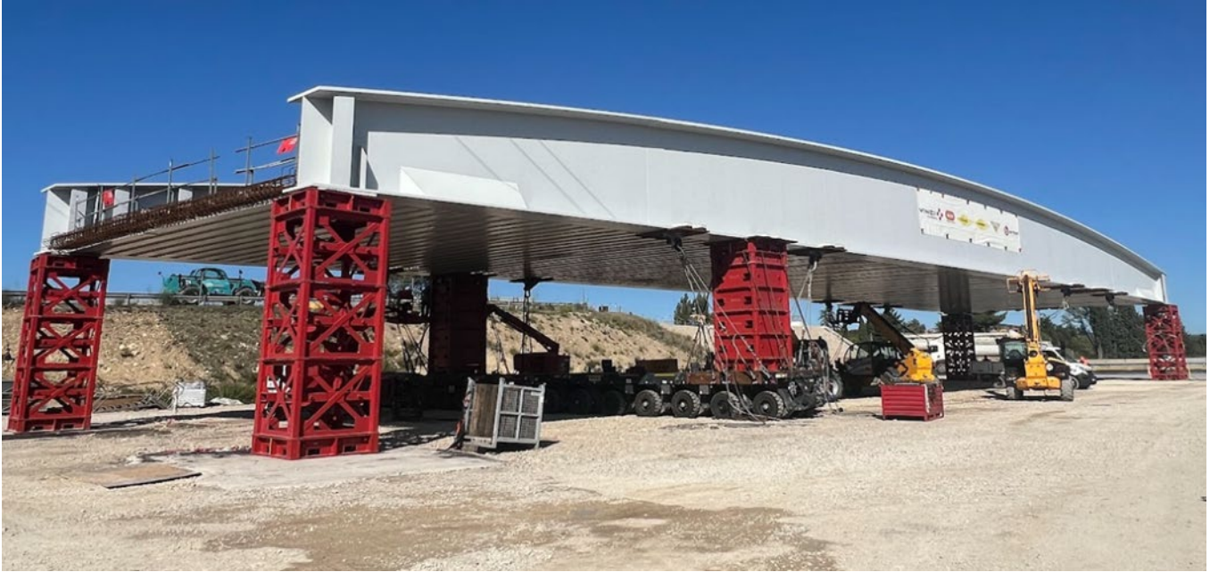
Prise en charge de la structure métallique par les Kamaq de notre sous-traitant Faiglioli.
