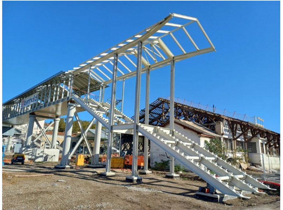
Montage des escaliers de quai à gauche et de l'escalier parvis Sud à droite
