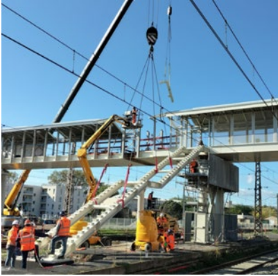
Montage des escaliers de quai à gauche et de l'escalier parvis Sud à droite
