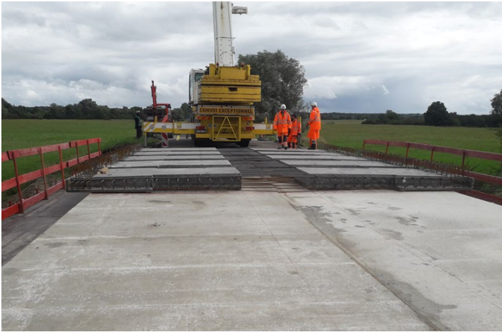
Pose des dalles préfabriquées
