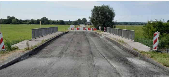
Décaissement de l'ouvrage
