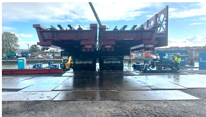
Prise en charge par Kamags et transport sur barge
