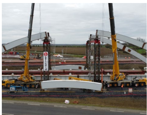
Image 9 : Mise en place des clés d'arc
