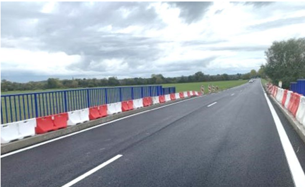
Fin de pose des dalles et réalisation des encorbellements métalliques y compris trottoirs d'abouts
