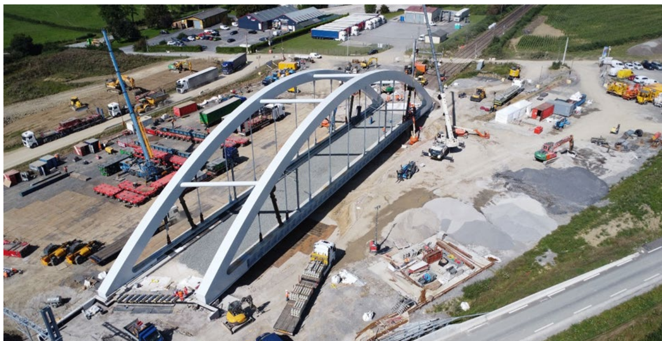
Image 11 : Reconstruction des voies sur l'ouvrage et repli de chantier
