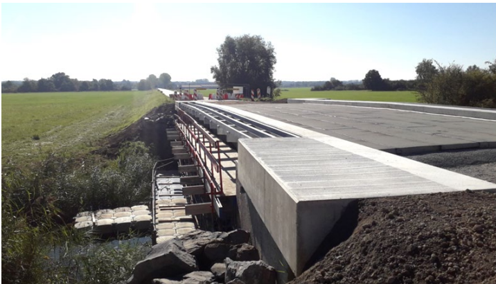
Fin de pose des dalles et réalisation des encorbellements métalliques y compris trottoirs d'abouts
