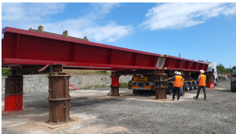
Auto-déchargement des tronçons et alignement des joints de chantier
