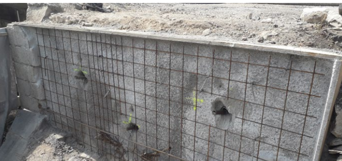
Reprise mur retour par tirants passifs et béton projeté
