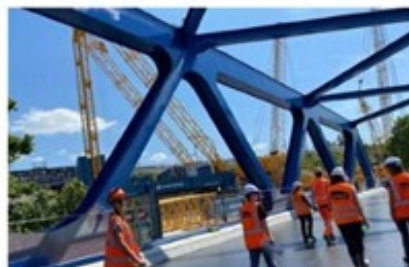
Les futurs ponts, peints en bleu roi, ont été soudés sur place et attendent d'être déplacés par la grue.
