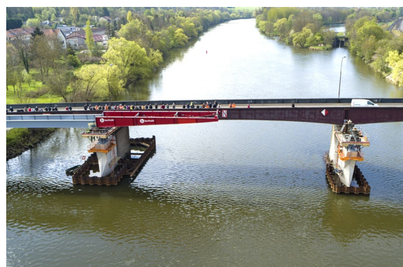
Opération de lancement des deux premiers bipoutres sur chantier – phase 01 – traversée de la voie navigable
