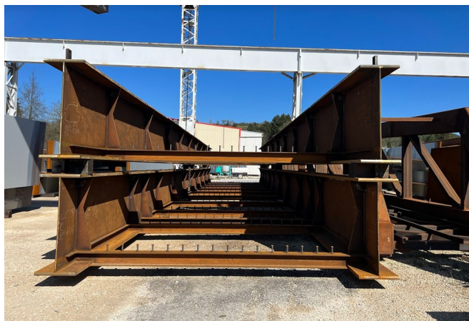
Dernières poutres en stock à l'atelier en attente de la mise en peinture dans les ateliers de BERTHOLD
