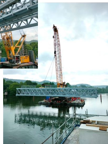
Grutage depuis une barge de la passe 3 de 100T à l'aide d'une grue treillis LR 1280
