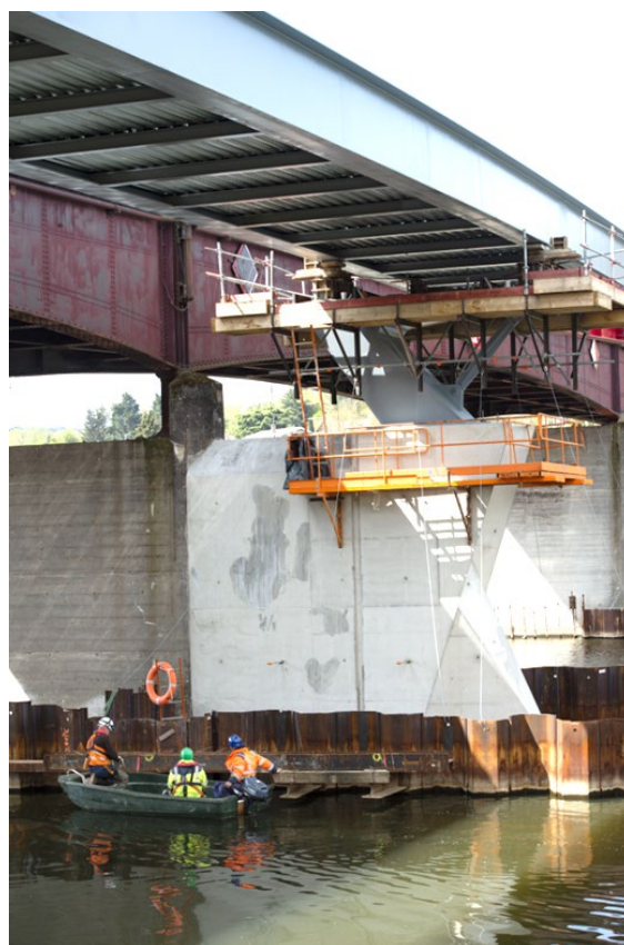
Elévation des piles métallique sur chantier.
