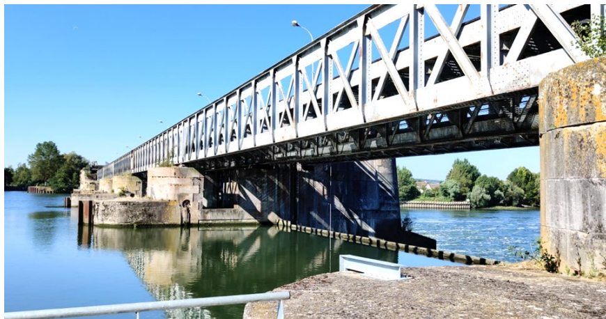
Barrage de Poses existant – structure rivetée type Eiffel – 250 m de long
