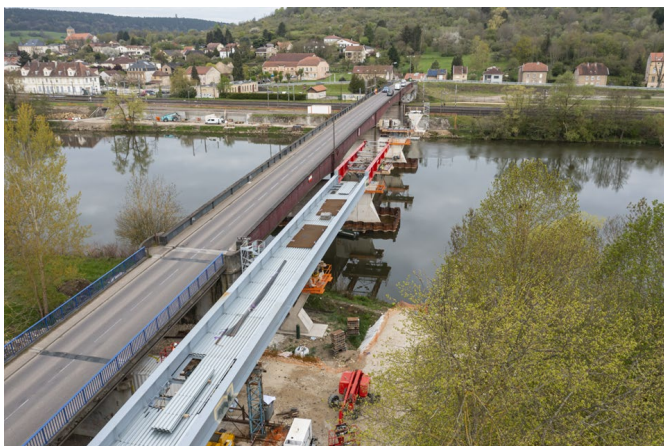
Opération de lançage des deux premiers bipoutres sur chantier – phase 01
