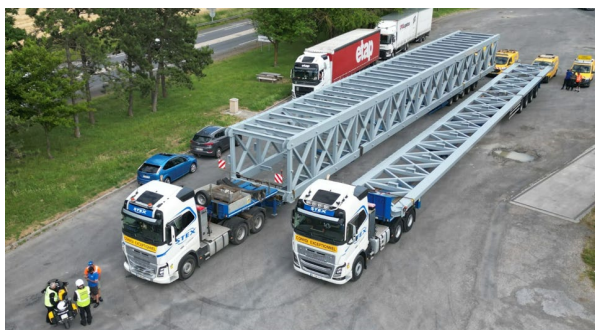
Livraison de la passe 2 - 34.5m de longueur - 4m de largeur
