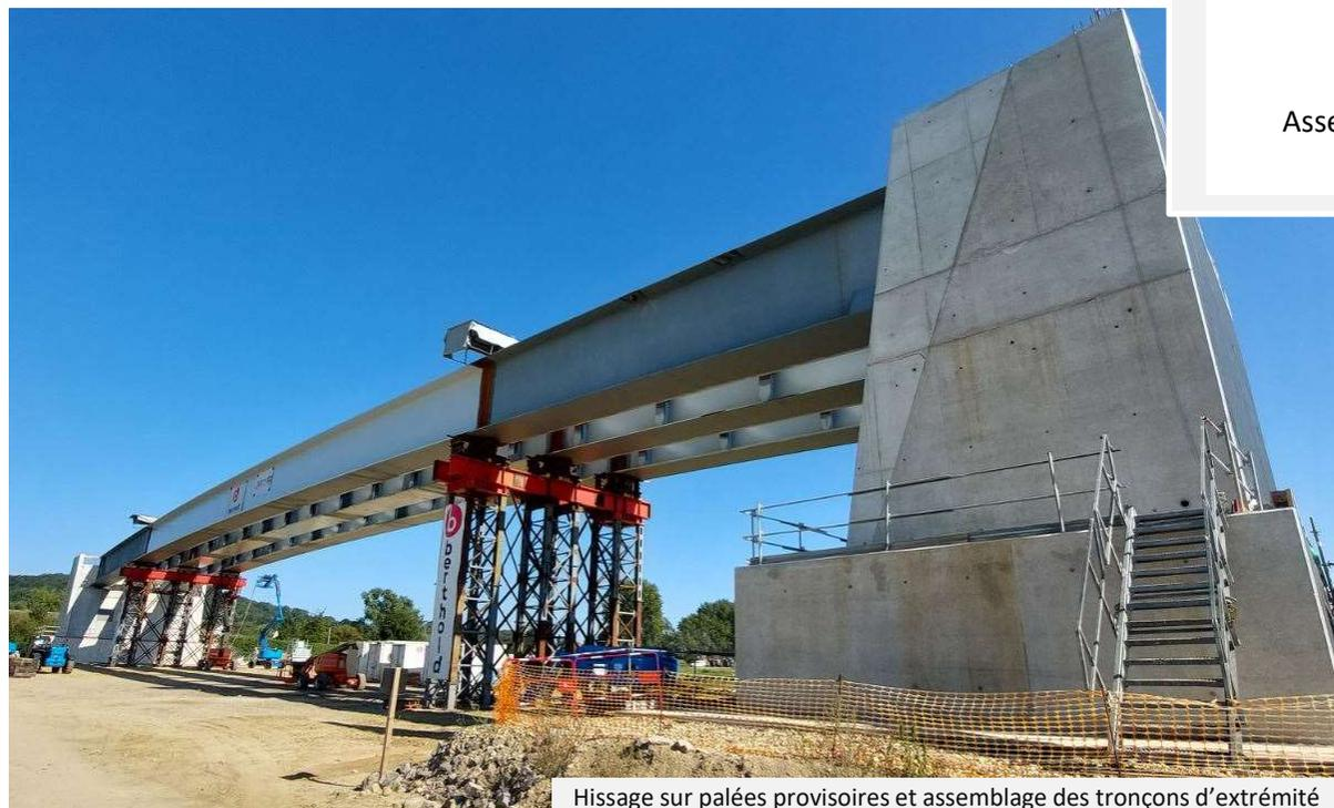
Hissage sur palées provisoires et assemblage des tronçons d'extrémité
