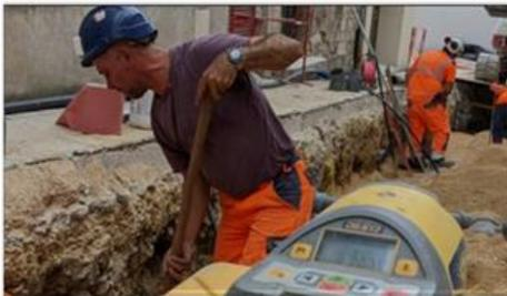
L'entreprise utilise un laser pour veiller au bon degré d'inclinaison et au niveau des conduits. « On ne peut pas utiliser d'outils plus modernes ici », remarque Samuel Heugebaert, chef de chantier. Photo ER/J.-B.M.
