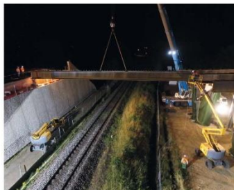
Pose de nuit de la travée sur la voie ferrée pour ne pas interrompre la circulation des trains
