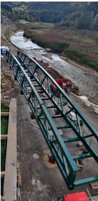
Montage sur plateforme de la passerelle + la grue 400 T
