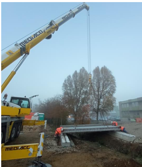
Pose tablier passerelle piétonne
