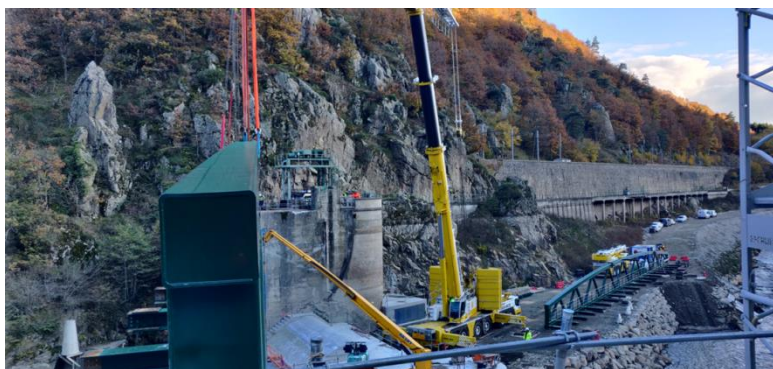
Opération de grutage de la passerelle
