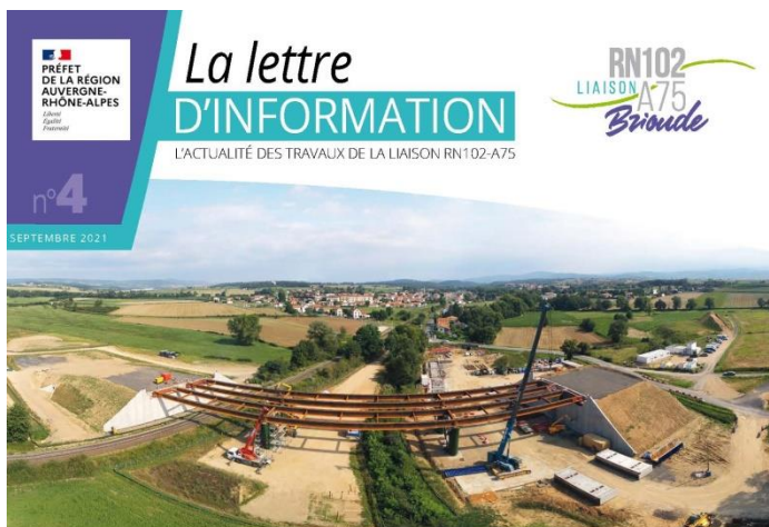
Le viaduc de la Leuge en cours de construction. En arrière plan, le bourg d'Arvant.
