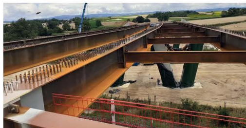
Charpente métallique du viaduc de la Leuge
