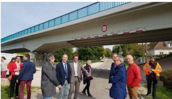
Inauguration officielle du pont de Void-Vacon vendredi après-midi par le président du conseil départemental Jérôme Dumont en présence de tous les acteurs de ce chantiers. Photo ER /Lionel MADELLA
