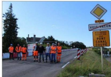
Les dates figurant sur le panneau de fermeture du pont ont été parfaitement respectées.
