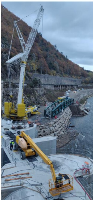
Montage sur plateforme de la passerelle + la grue 400 T
