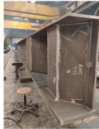
Fabrication d'une poutre principale en atelier
