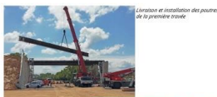
Livraison et installation des poutres de la première travée
