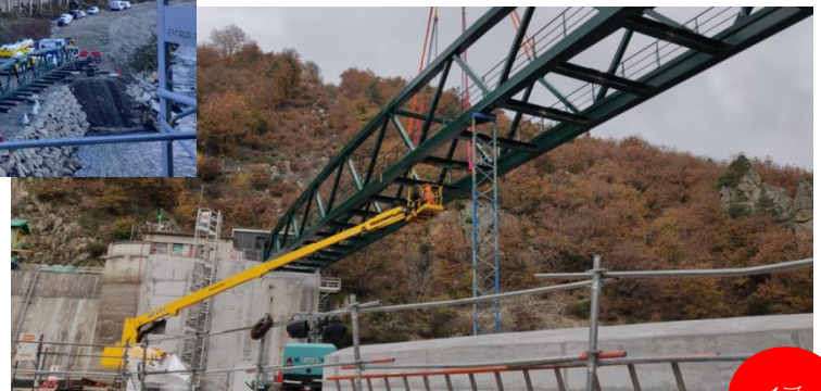
Opération de grutage de la passerelle
