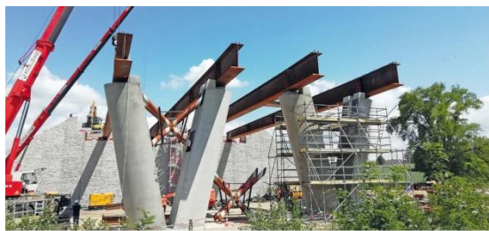
Les poutres de la première travée sont maintenant posées sur les appuis. Les croix de Saint-André sont installées et retiennent les deux fils de la pile.
