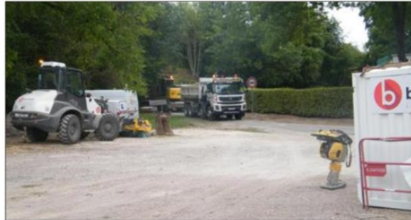
Le ballet des engins de travaux publics est le signe tangible de l'arrivée de la fibre.
