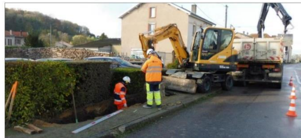
L'entreprise Berthold-Sogea intervient sur la commune de Dombasle, pour le déploiement de la fibre.
