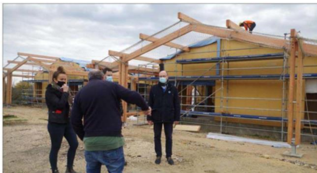
La structure en bois prend forme et permet de voir les différents espaces. Photo ER
