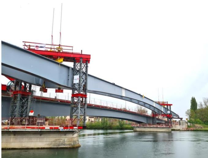
Opération de déhissage de la charpente métallique neuve
