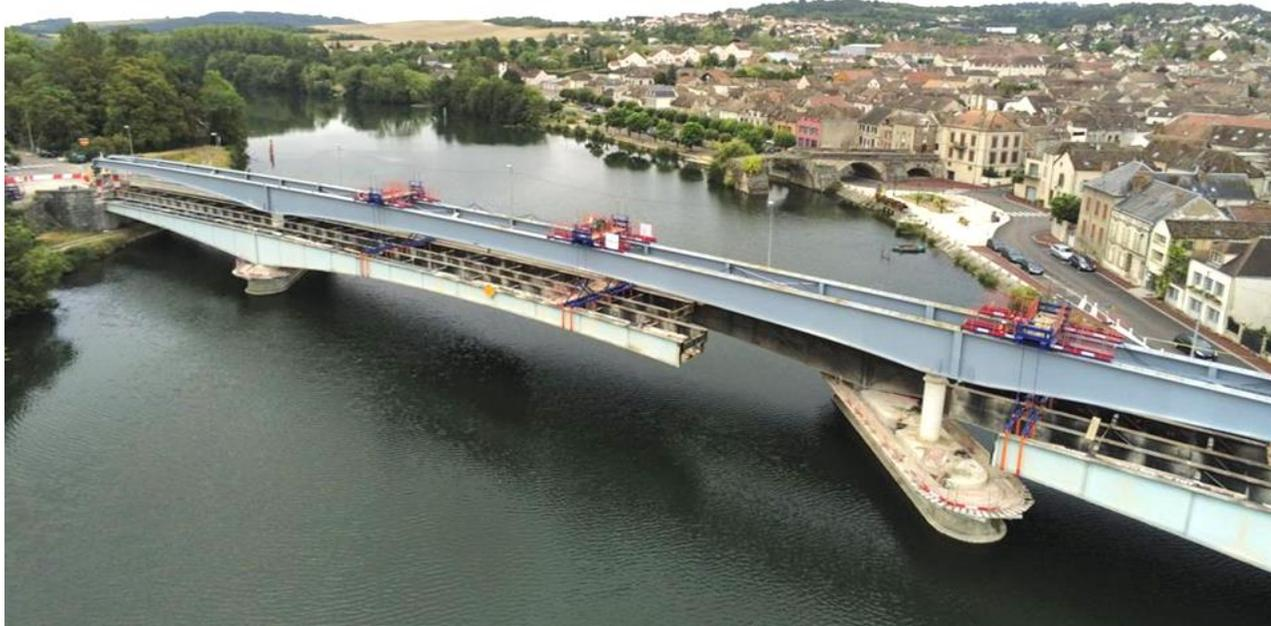
Délançage de l'ouvrage existant depuis la charpente métallique neuve
