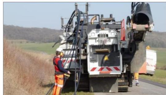
La trancheuse permet de creuser le terrain avec précision, et de remblayer simultanément.
