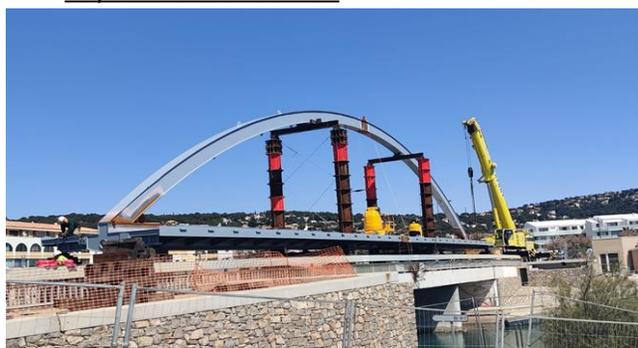
Mise en place des arcs sur les palées provisoires
