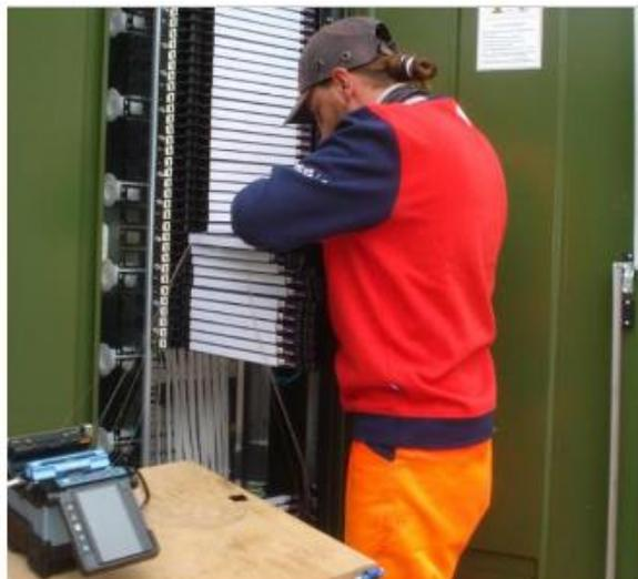
**L'armoire SRO où sont connectés les brins de fibre optique.**
