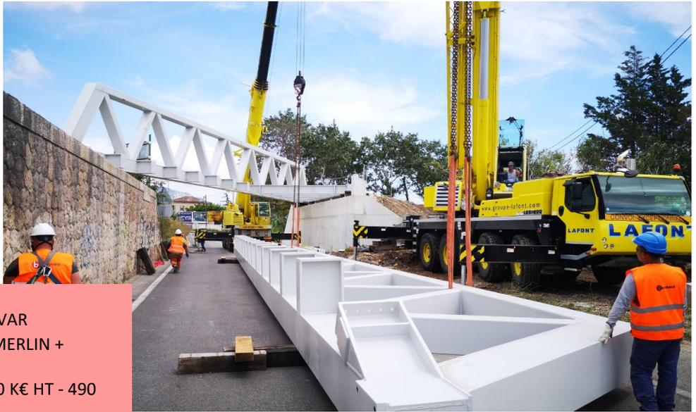
*Mise en place de la poutre treillis T21 à l'aide de 2 grues 100t*
