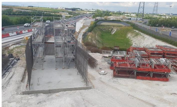
*Ferraillage des murs de soutènement*
