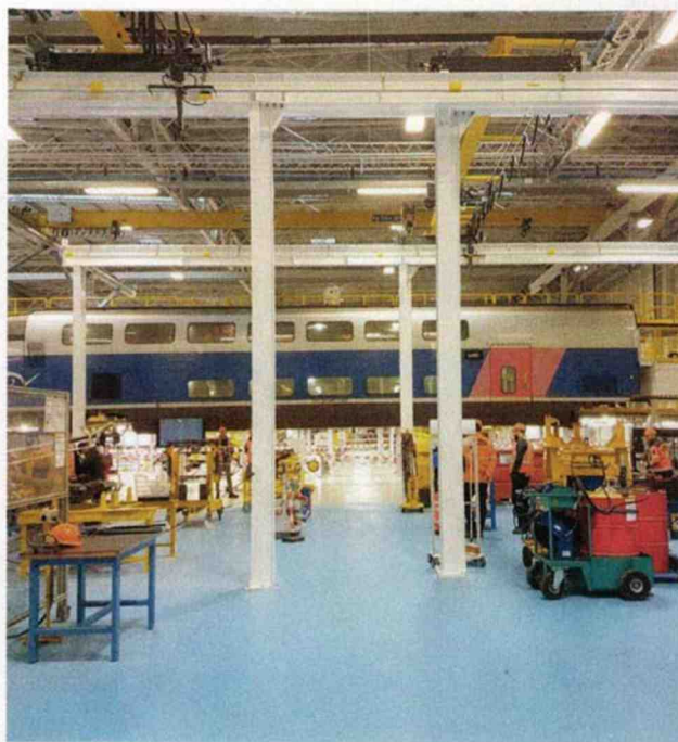
L'atelier 57 comporte de grandes portées (62 mètres dans sa partie centrale) et une hauteur libre de 12,5 m sous plafond.
