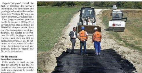
À la fin de la rue de l'Arène, le chemin est en passe d'être terminé. Photos Franck LALLEMAND
