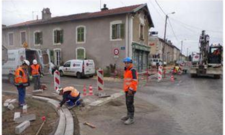
Le chantier bloque le carrefour. Photo ER
