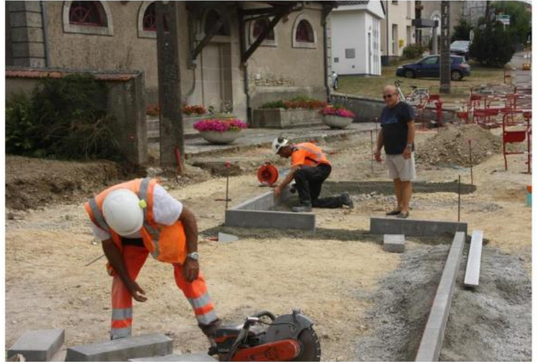
Les travaux d'aménagement de la placette devant l'ancien lavoir par le personnel de l'entreprise Berthold, sous le regard du maire André Dormois en visite de chantier. Photo ER
