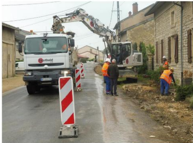
Outre la mise en place de nouveaux ralentisseurs, l'entreprise a également rehaussé des caniveaux.
