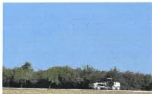
Les engins de chantier s'affairent sur les chemins verdunois.
