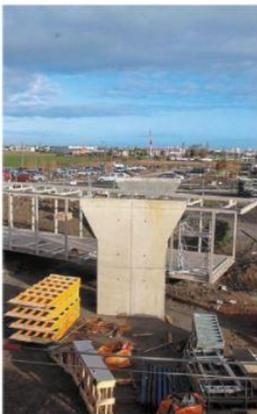
Les fondations sont prêtes pour « accueillir » la nouvelle passerelle métallique qui fera la jonction vers le parking nord. **PHOTO: P. H.**
