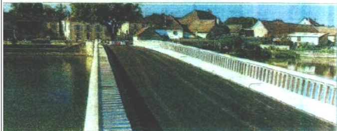
Les trottoirs antidérapants ont été aussi réalisés.
