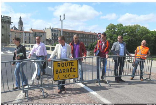
Cinq semaines de travaux ont été nécessaires pour donner un nouveau revêtement au pont Chaussée. En Verdun
