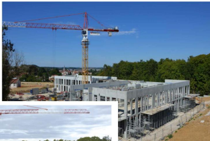
Atelier 1 - Pose de la charpente métallique — Septembre 2015
