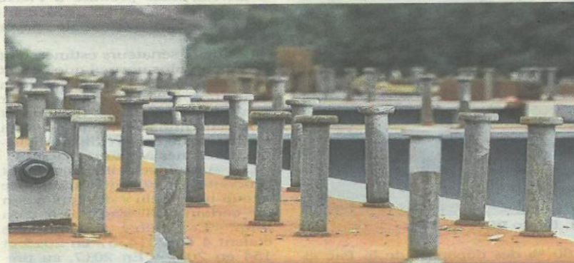
Des centaines de goujons ou connecteurs sont disposées sur les éléments métalliques. Ils assureront la liaison avec le futur tablier.
