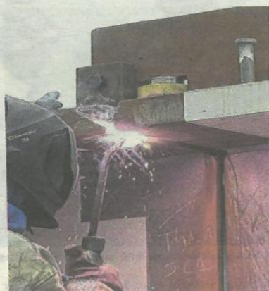
Le pointage des éléments pour stabiliser l'ensemble, est commencé.
