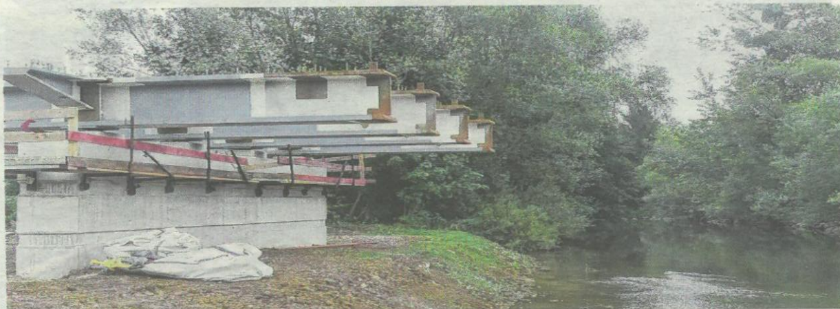
La seconde travée, constituée des plus longues poutres métalliques, sera mise en place après le 15 août. Photos X.C.
