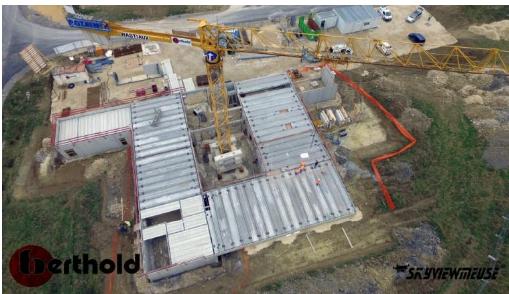
Photo en cours de chantier
