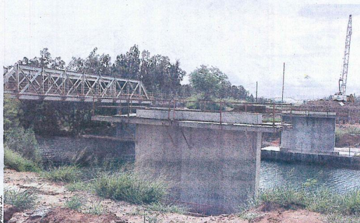
Janvier 2017, pont de la Ouenghi. Depuis une semaine, les ouvriers coulent des culées destinées à recevoir les poutres métalliques, puis le tablier en béton du nouveau pont. La fin des travaux est prévue pour le second semestre 2017.
