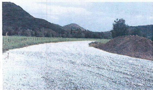
La RT1 sera détournée d'une vingtaine de mètres. Une opération qui n'aura « pas d'impact », selon la DITTT.
