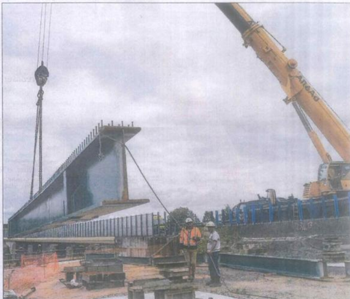
La charpente, livrée en six morceaux, a été posée sur une plate-forme d'assemblage, où elle sera soudée avant de prendre sa position définitive cet hiver. Photo Thomas KIRSCH
