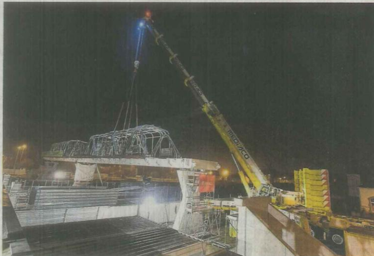
L'opération s'est déroulée nuitamment pour ne pas perturber le trafic ferroviaire. PHOTO DNA - F.K.
