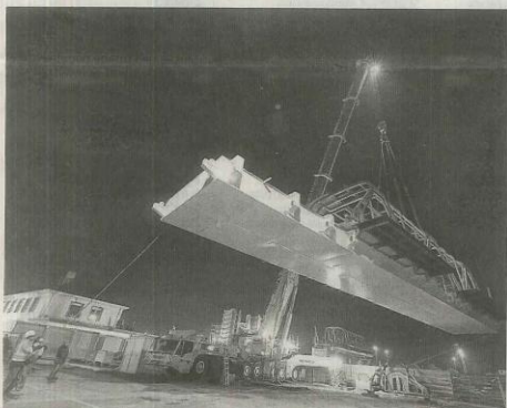
Il y avait beaucoup de monde jeudi soir sur le parvis de la gare de Haguenau pour assister à la spectaculaire opération de grutage. Cette étape cruciale du chantier s'est déroulée notamment pour ne pas perturber le trafic ferroviaire.
