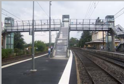
Passerelle piétonne- MONTLUEL (01)
