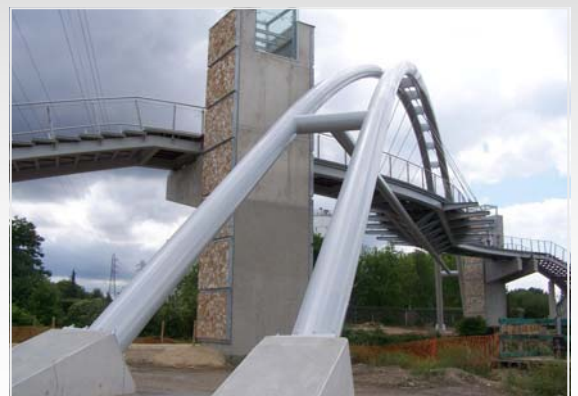
Passerelle de franchissement - NANTERRE (92)
