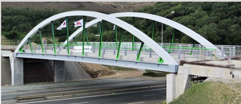
Pont de KO WE KARA - NOUMEA (Nouvelle Calédonie)
