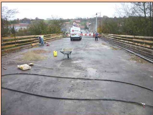
Après décaissement de la chaussée et des trottoirs
