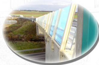
RN 4 - Déviation de Bebing Imling (57)
